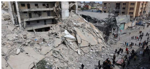
Un bloque de viviendas yace en ruinas en el barrio de Al-Shaboura, en la ciudad de Rafah.
