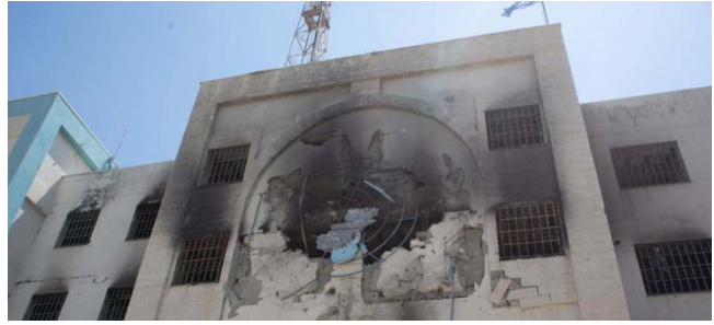
Esto es lo que queda de la oficina del UNRWA en la ciudad de Gaza.
